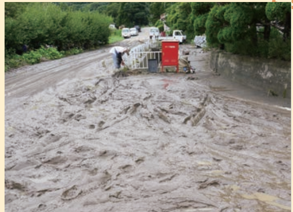
【古屋地区:平成23年9月4日 紀伊半島豪雨23年災】 和歌山県下で53名の死者が発生し、印南町でも印南川・切目川下流域で浸水害が発生しました。
