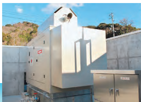
↑非常用発電機
