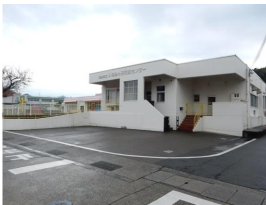
印南町立いなみっ子交流センター
