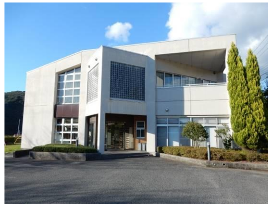
切目川防災センター
