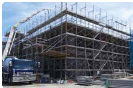
庁舎建築現場
