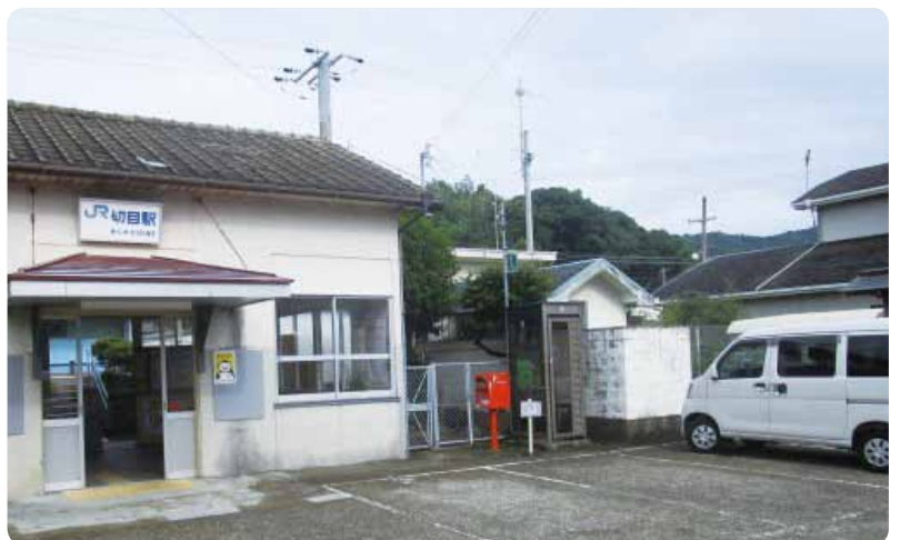
切目駅前公衆便所
