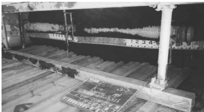
宮ノ前の農業集落排水事業工事の管工事の一部
