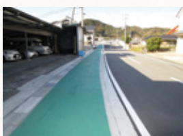
印南町停車場水越線への歩道
