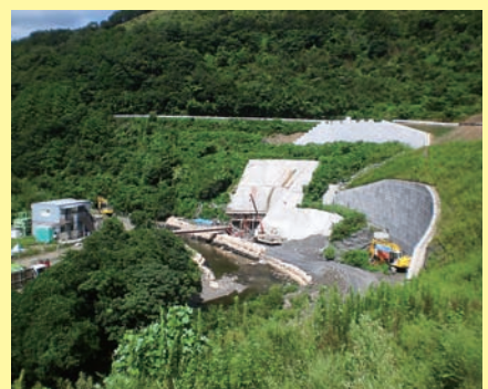
▲転流工施工現場
