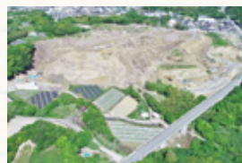
統合中学校建設事業
