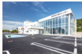
印南町防災福祉センター建設事業
