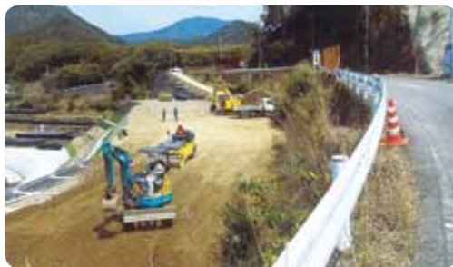
着々と進む工事現場
