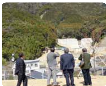
山腹崩壊後の堰堤工事
