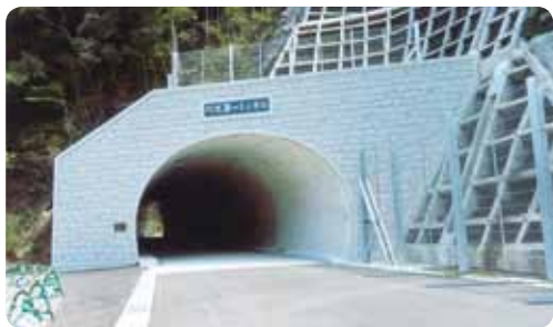
川又第1トンネル (全長 151 m)
