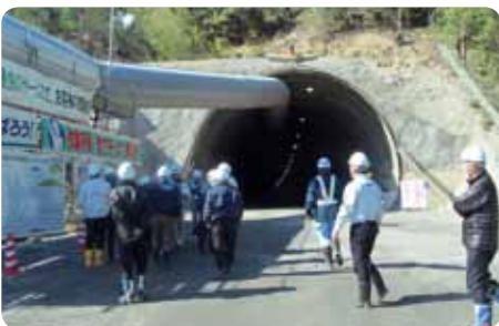
高速道路トンネル工事(廃土)
