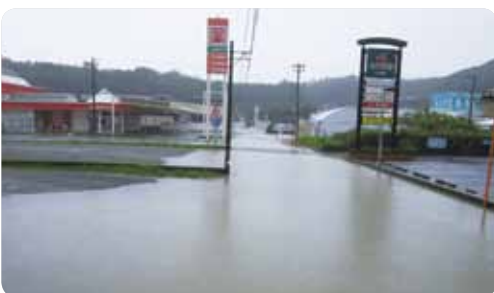
商業施設周辺内水
