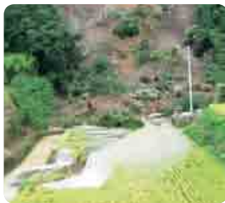
土砂災害（櫻川地内）
