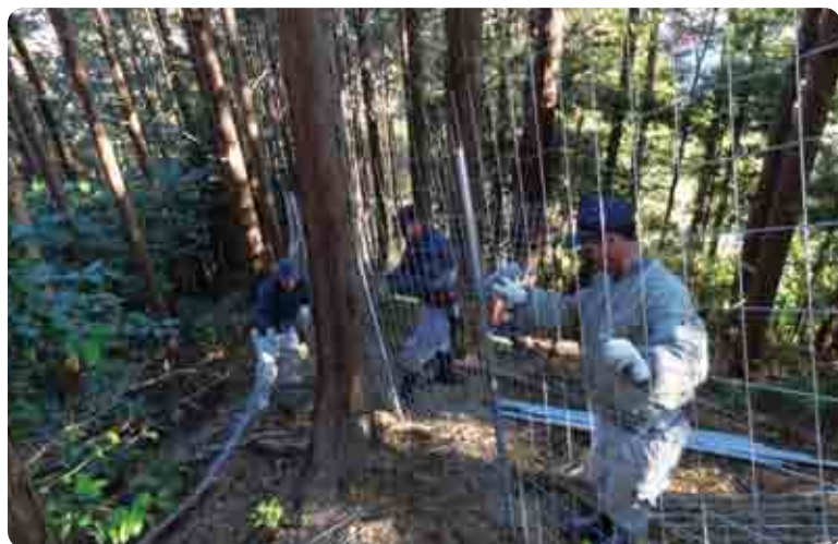
防護柵を設置しているところ
