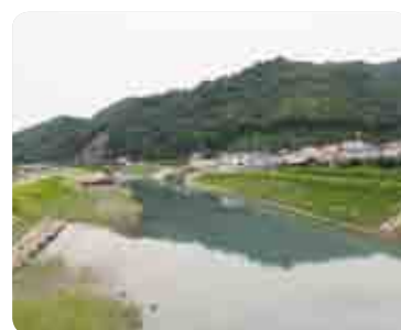
切目川河川改修
