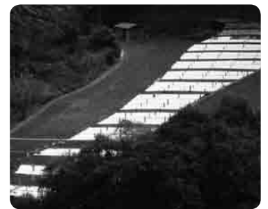
事業実施後の施設
