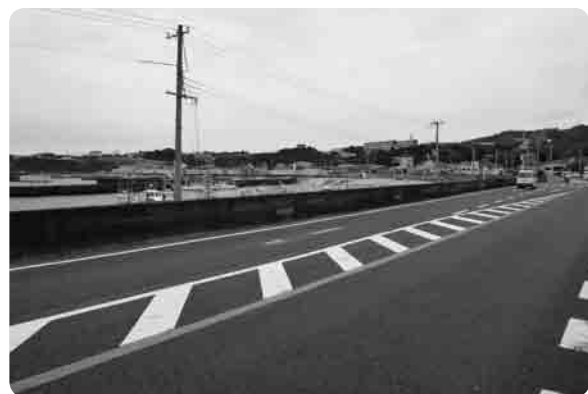
印南湾の防潮堤(国道路面で海拔5、6m)
