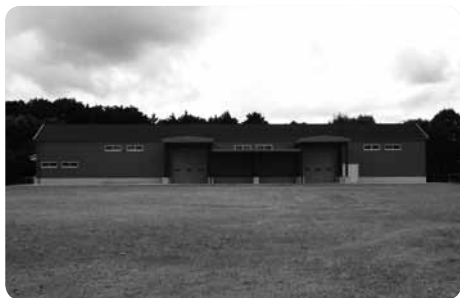
上野山防災広場備蓄倉庫
