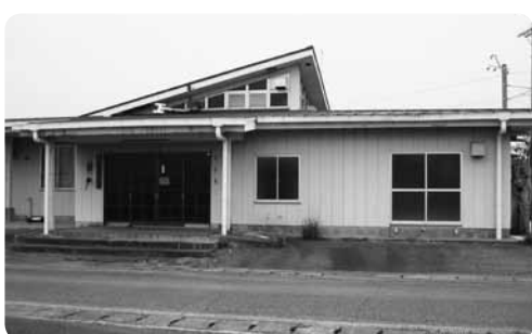
旧切目パン工場が改修され障害者支援施設へ
