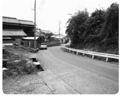
高速道路印南インターチェンジより役場方面
