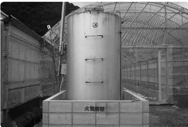
防油堤の設置
