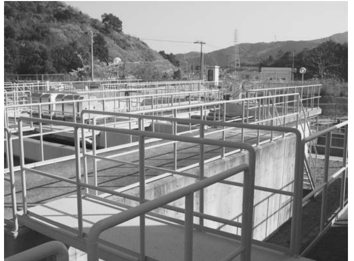
印南浄水場浄化施設（より安全な水道水を各家庭に...）
