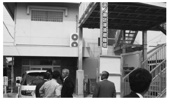
美浜町浜ノ瀬の避難塔
