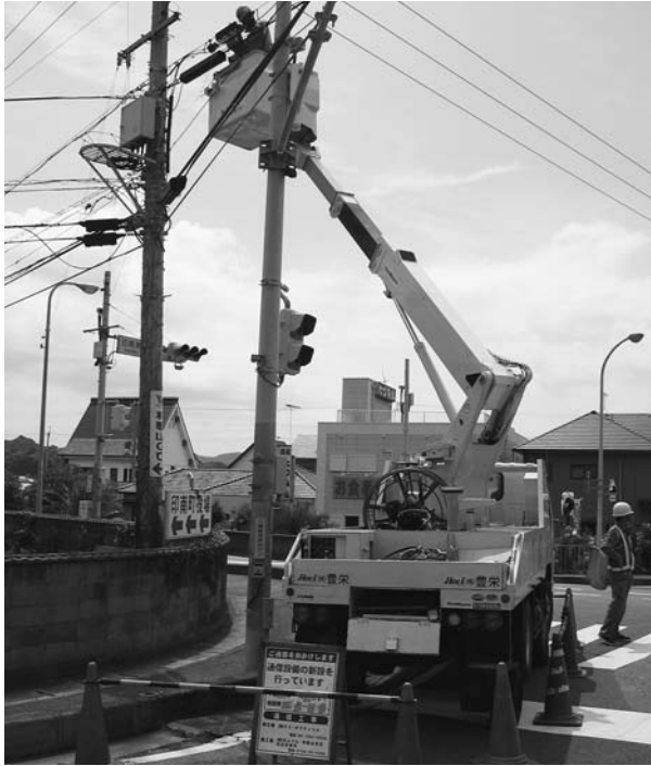
光ケーブルが敷設。光通信が可能に。
