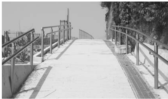
要害山避難道路を改修
