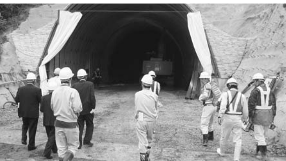
切目川1号トンネル工事現場
