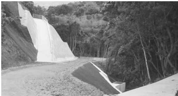
崎山地区農道整備工事
