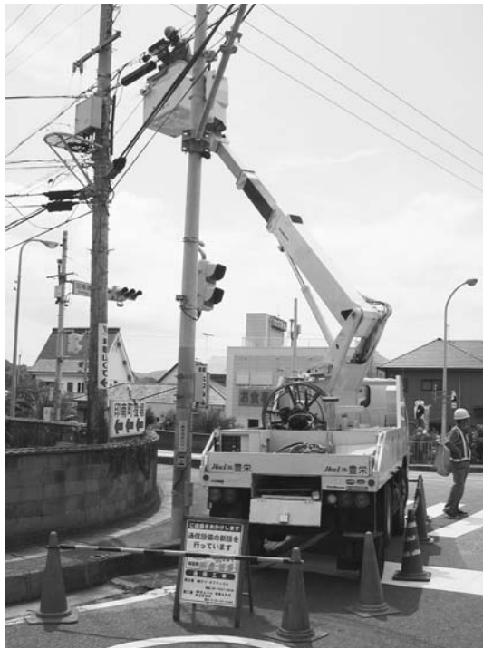
町内各地でeo光の工事が進む
