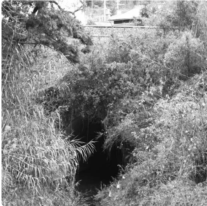
J R線を横断する暗渠排水
