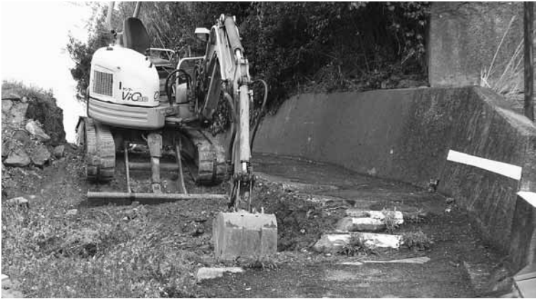
工事が進む要害山避難道路
