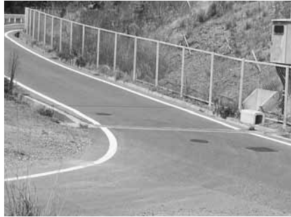
一般道からSAへの進入路を整備
