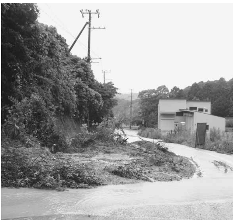
大雨での土砂崩れは生活にも支障をきたします。
