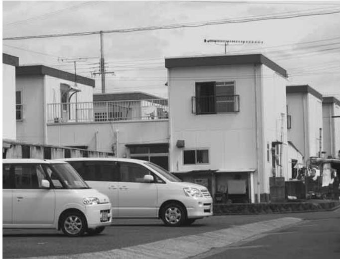
上道改良住宅
