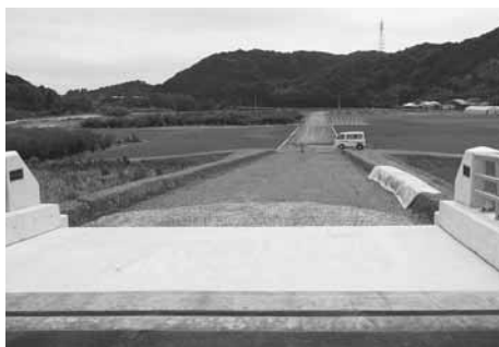
工事が進む黒潮フルーツライン
