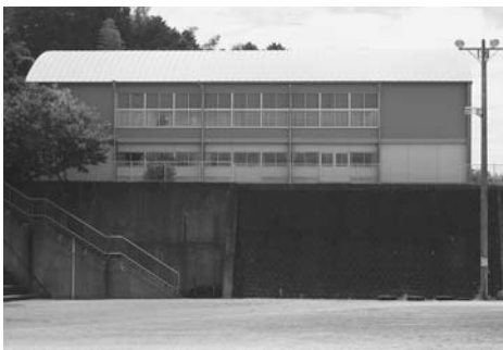
稲原中学校屋内体育館
