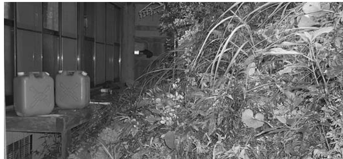
住宅裏山の崩壊現場
