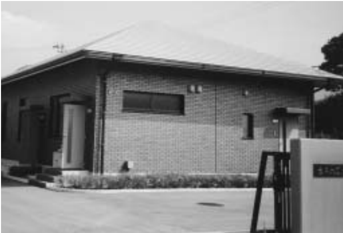
古井地区農業集落排水処理施設
