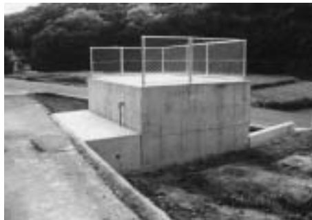
完成した防火水槽
