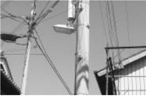
避難灯を設置
