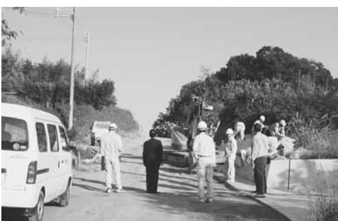
改修が進む柳畑白河線を踏査
