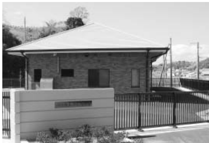
完成の山口処理施設
