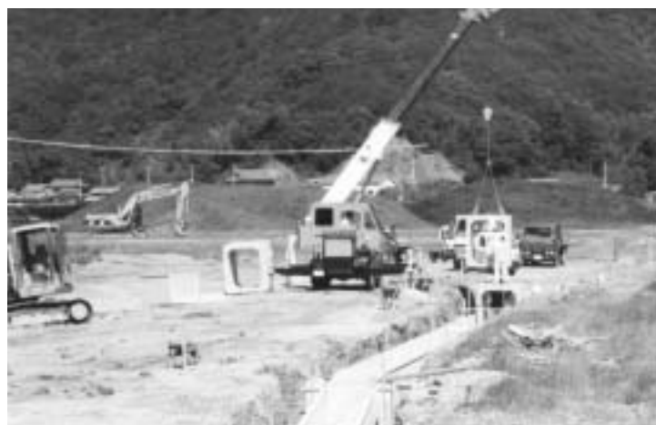
フルーツライン事業のほ場整備が進む
