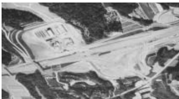
パーキング立上げを待つエリア
