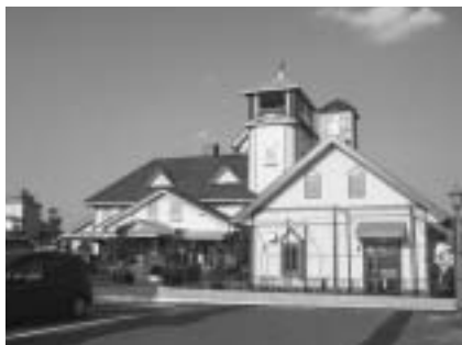
田園生活館全景
