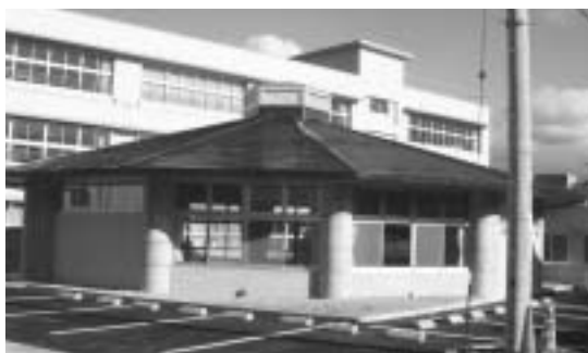
完成した印南小のランチルーム
