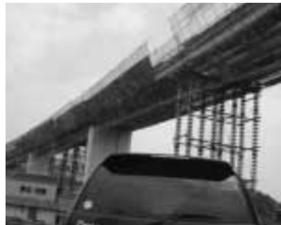
印南インター橋の下から
