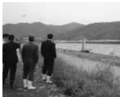
切目川河川改修現場
