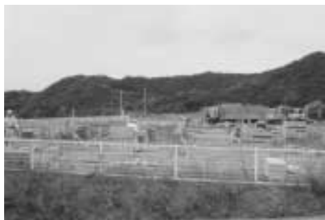
ホーム建設現場
