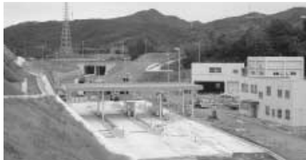
完成間近の料金所
