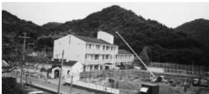
切目川小学校屋内運動場（建設工事中）
