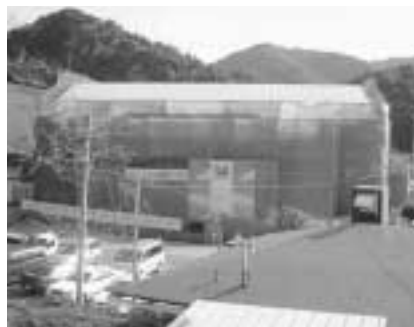
切目川小学校屋内運動場建設中
