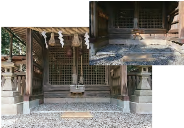
↑拝殿基礎工事(上:修理前、下:修理後)
