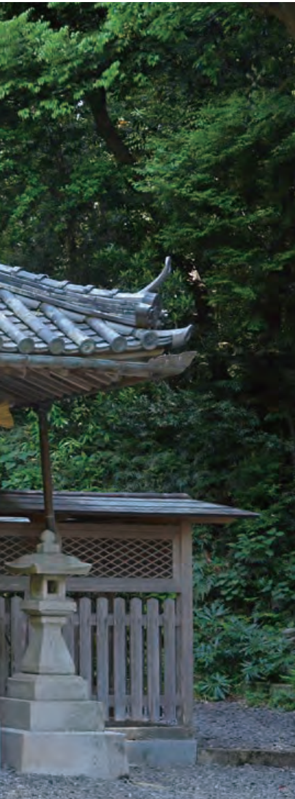
←屋根の葺き替え工事が完了した切目神社
