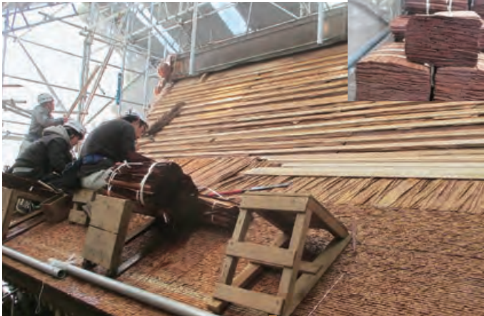
↑葺師による葺き替えの様子
