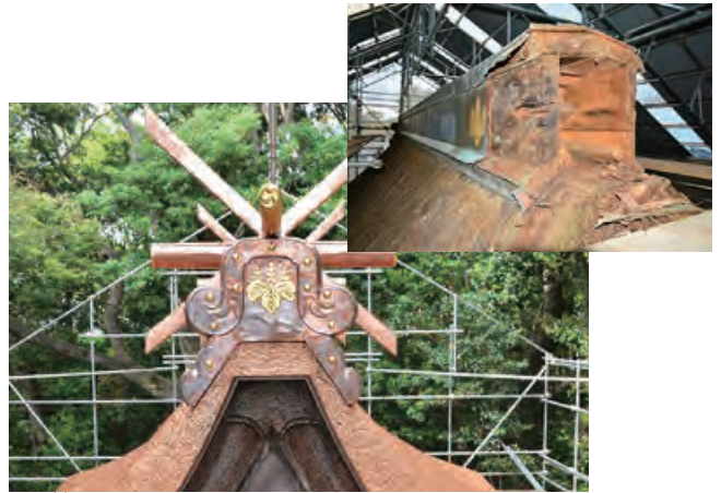
↑箱棟修理(上:修理前、下:修理後)
