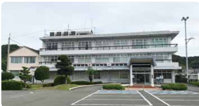
解体予定の旧庁舎
