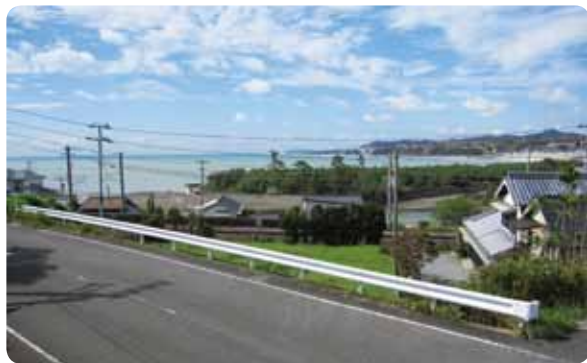
島田農免道路付近
