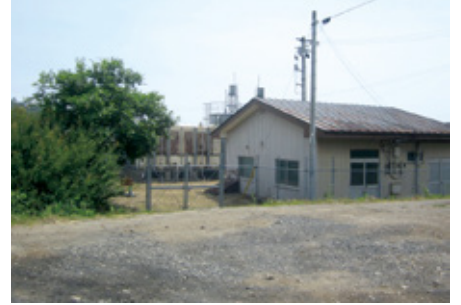
滝ノ岡水源地
