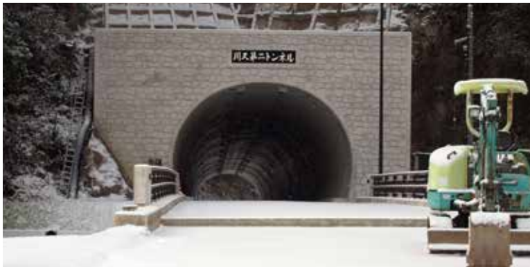
川又第2トンネル
