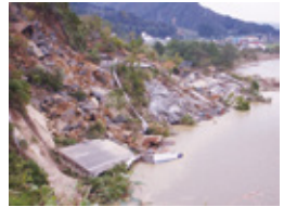
[新潟中越地震により崩落した国道17号(妙見町)]
