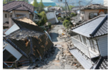
〔熊本地震 被害写真〕
