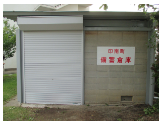
〔切目地区〕 切目小学校北側倉庫
