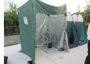
〔マンホールトイレ〕
