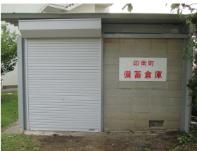
〔切目地区〕 切目小学校北側倉庫
