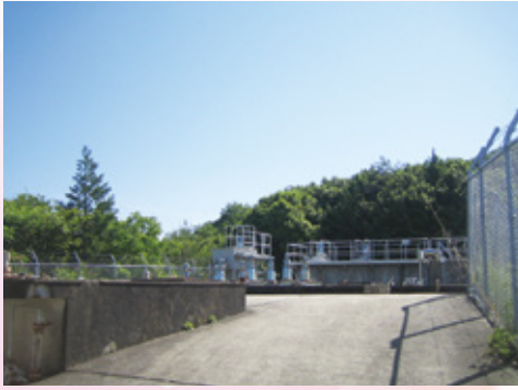
印南原浄水場
